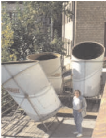
Крыша здания ИФА, 2005 г.
